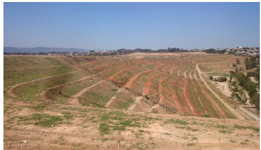
Células de aterragem finalizadas, com destaque para a preparação da cobertura vegetal em taludes e bermas. Fonte: CEMP/SLU
