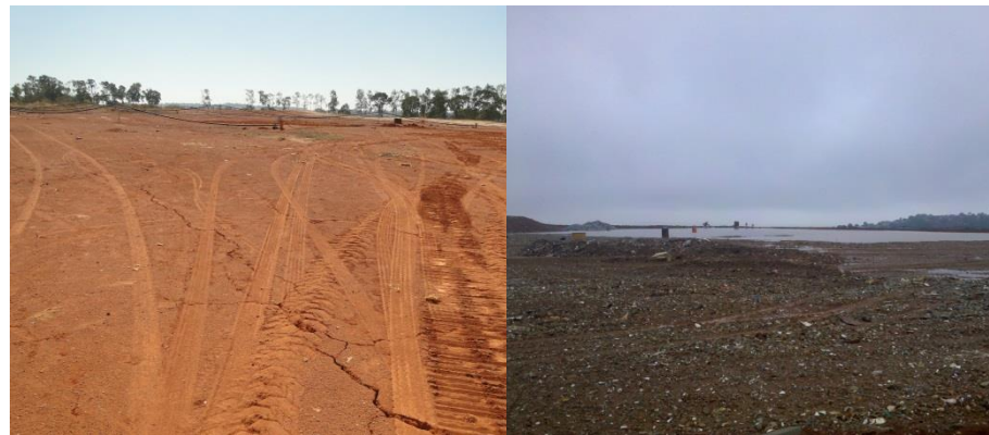
Trincas na camada de cobertura devido a recalques
